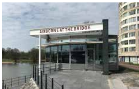
Airborne at the Bridge: getransformeerd van functie horeca naar bezoekerscentrum Slag om Arnhem.
